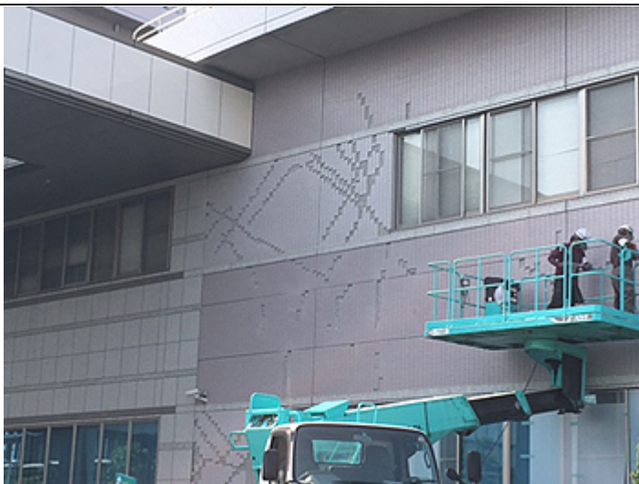
壁の修復作業
