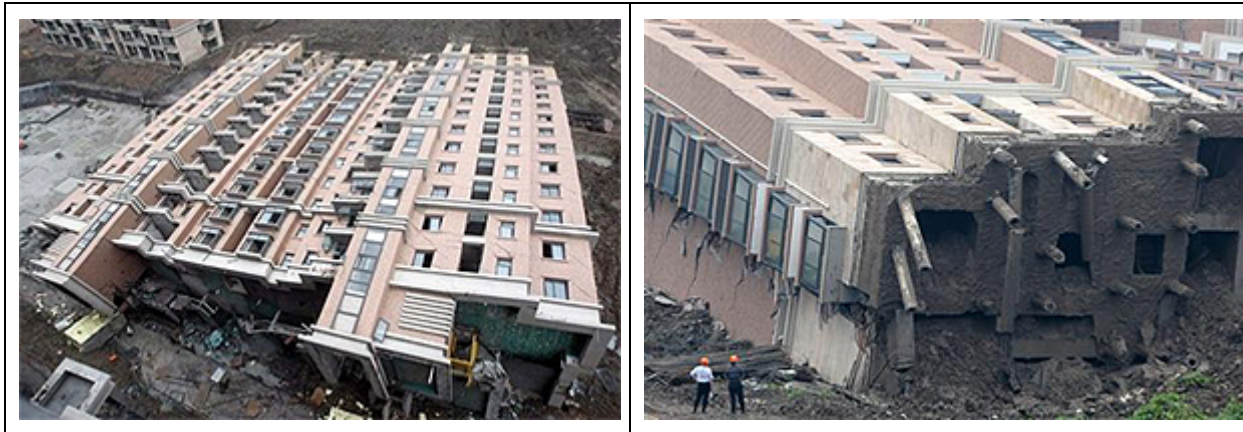
—建設途中の 13 階建てマンションが倒壊 上海市— 不動産バブルもこのように崩壊か!?
